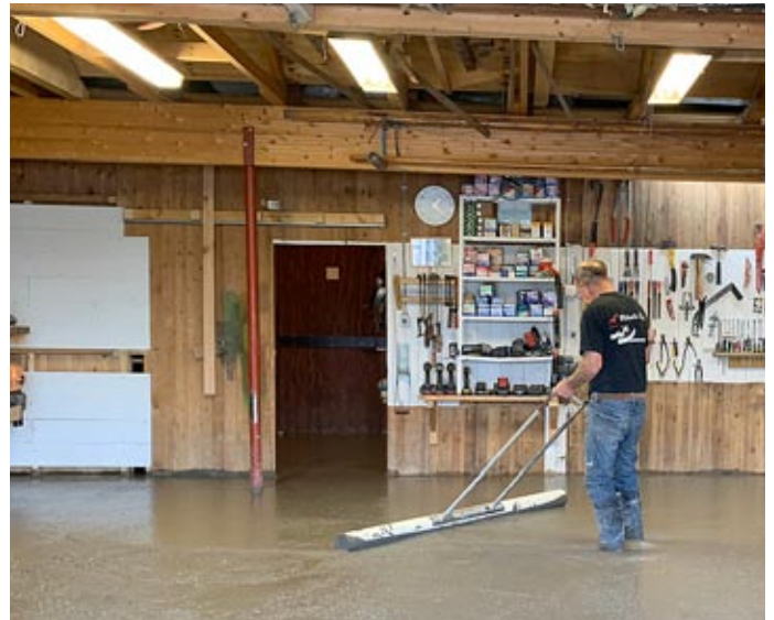
I efteråret blev der støbt ca. 22 cm oven på det eksisterende gulv, så gulvhøjden er ens i hele bygningen. Her er Preben Hasselstrøm ved at glatte overfladen på betonen. Foto: Richard Jensen
