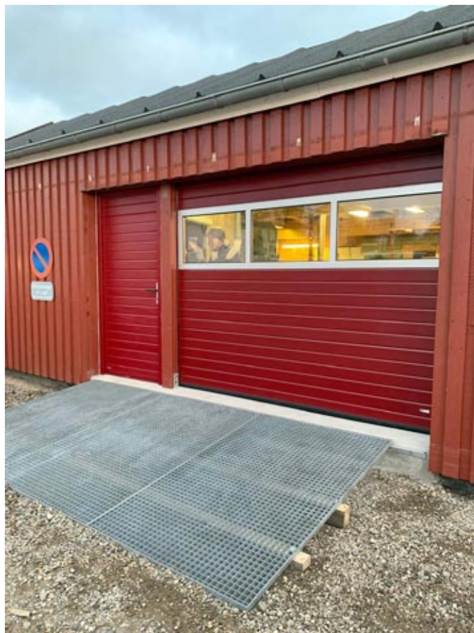
Den nye port er fabriksmalet i en rød farve, og er med til at bryde den lange facade på bygningen. Lauget har høstet meget ros fra byens borgere og brugere af havnen. Foto: Richard Jensen
