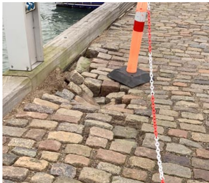
Brostenene ved bolværket bliver undermineret flere steder af den skiftende vandstand. Foto: Richard Jensen
