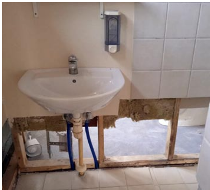
På toiletet og i baderummet er der isoleret med fugtsugende isolering.
